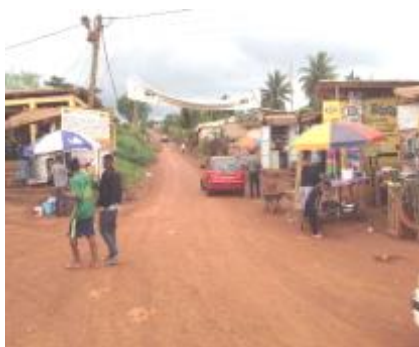
Photo 33 : Sortie de la voie de contournement à Nkolnda II partie urbaine du tracée
