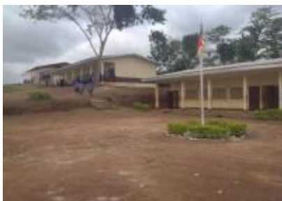
Photo 15 : Lycée de Mbela
