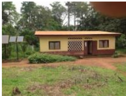
Photo 23 : Centre de Santé intégré de Nkolmefou I
