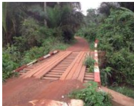
Photo 34 : ouvrage de franchissement sur la route de contournement
