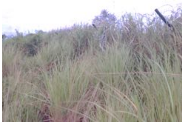
Photo 3: Partie de la route de patrouille envahie par les herbes près du VOR
