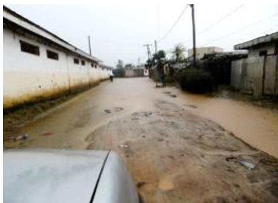
Photo 8 : Inondation par les eaux venues de la zone aéroportuaire
